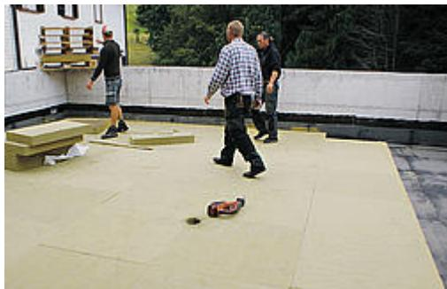
Trittweise Dämmplatte für den Einsatz in Flachdächern, welche für eine Nutzung durch Personen und/oder für Installationen vorgesehen sind. Als Kerndämmung bei zweischaligen Betonwänden.
