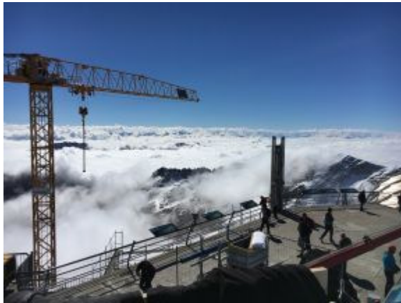
Dachterrasse mit begehbaren GLAPOR-Schaumglasplatten ohne Endbelag
