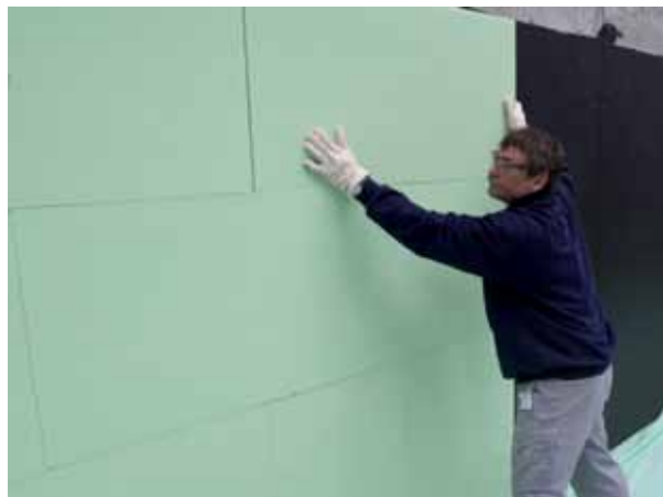
Styrodur isoleringspladerne presses ind i klæbelaget bestående af PCI Pecimor DK.
